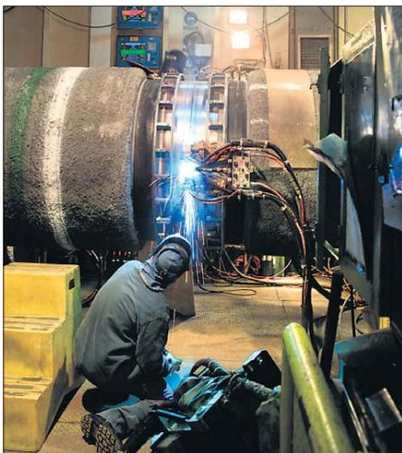
In dieser Kammer – nicht größer als eine Apollo-Kapsel – werden die Pipeline-Enden am Meeresboden zusammengefügt (oben). An Land üben Arbeiter schon das Anschrauben und Schweißen der Ränder. Foto: Nordstream
